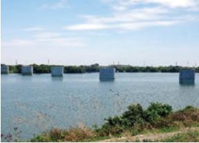
新濃尾大橋(仮称) 令和5年前後完成予定
