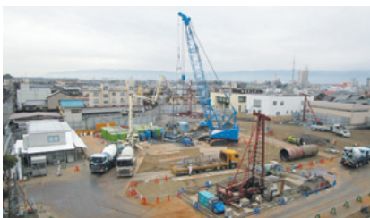
令和3年開庁に向けて工事が始まる。
