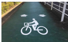
路面標示の例
