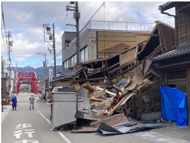
<石川県輪島市の被災後の様子>
