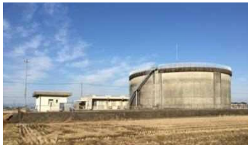
写真 2-1 小熊水源地の配水池
