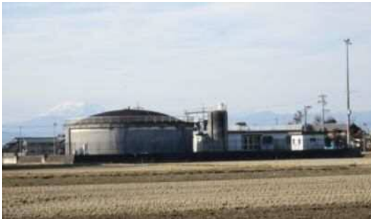
写真 2-3 桑原水源地の配水池
