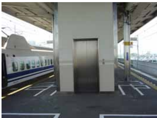
構内のバリアフリー化(昇降装置の設置)
