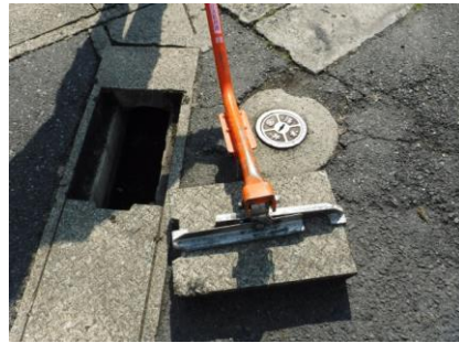
⑤ふたを安全な場所に移動させ、アームをはずします
