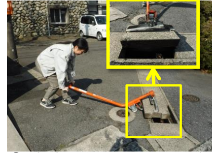
③爪部がふたをつかんでいることを確認し、ハンドルを押し下げてふたを持ち上げ
