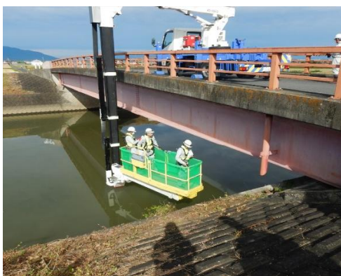
近接目視による点検状況（橋梁点検車、高所作業車）
