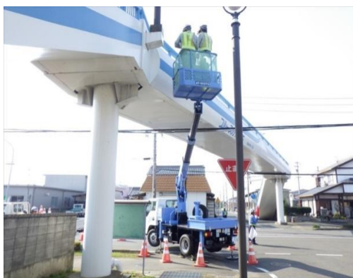
近接目視による点検状況（橋梁点検車、高所作業車）
