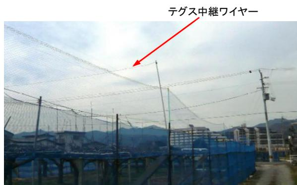
写真14 テグスの下支えにワイヤーを設置した例
