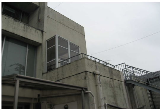
⑥南側2階裏口(下から撮影)
