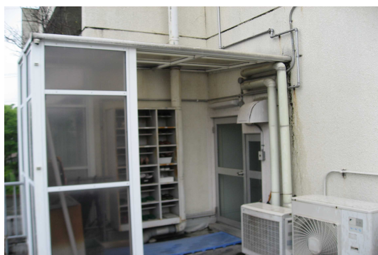
⑦南側2階裏口
