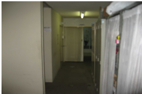
⑩廊下(トイレ・機械室)
