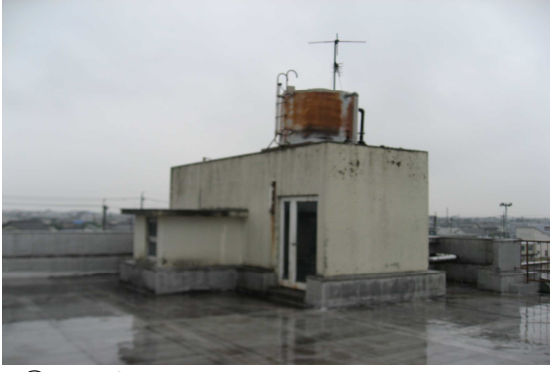
⑤屋上出入口
