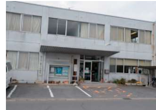
足近コミュニティセンター耐震補強事業
